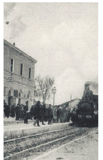
LA VECCHIA stazione ferroviaria di Canosa
