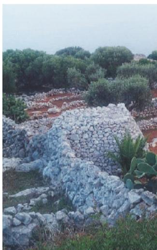
Muretti a secco
